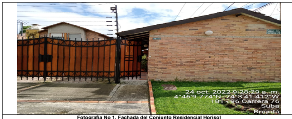
Fotografía No 1. Fachada del Conjunto Residencial Horisol
